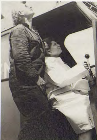
Mevrouw Schmitz, wethouder van Volksgezondheid, slaat op 21 juni 1980 de eerste paal voor De Patio.
